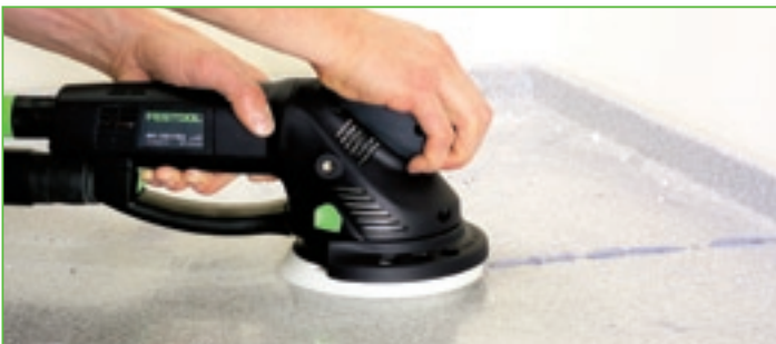
Przy usuwaniu nadmiaru kleju po sklejeniu krawędzi materiałów mineralnych.
